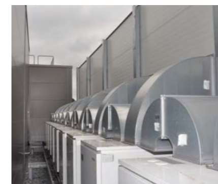
Hinter der Sichtwand: 10 Luft-Wasser-Wärmepumpen WPL 23 cool von STIEBEL ELTRON
