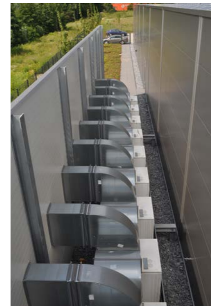
Hinter der Sichtwand: 10 Luft-Wasser-Wärmepumpen WPL 23 cool von STIEBEL ELTRON
